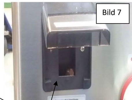
Externes Verlängerungskabel durch die Gummitülle stecken. Das externe Wandgehäuse montieren, mit dem Bedienteil und dem externen Kabel mittels Stecker verbinden.
